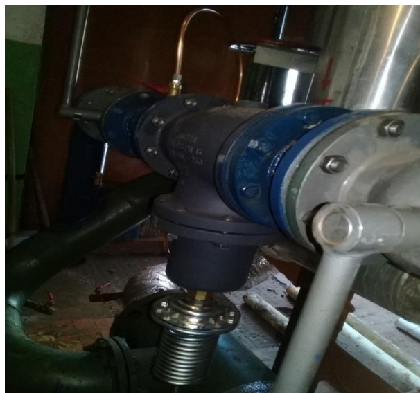
Рисунок 1. Регулирующие клапаны: а – регулятор давления на систему отопления VGS211F; б – регулятор перепада давления VFG 2 и регулирующий клапан V222; в – регулятор давления «до себя» VFG 2.
