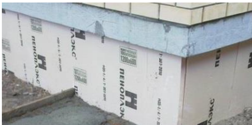
Рисунок 3 – Утепление фундамента.
